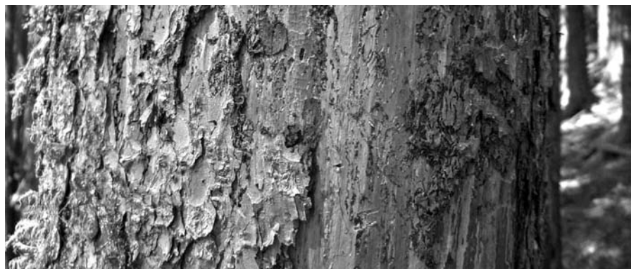
Stammbereich bereits abgestorben
